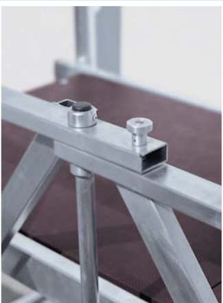
Шарнир складного модуля
